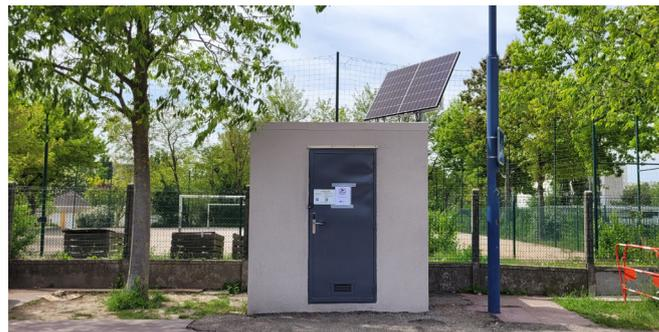
*Shelter équipé d'une solution solaire autonome*
