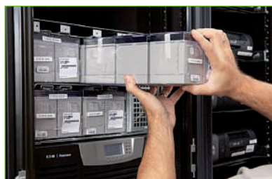
Modules de puissance remplaçables à chaud
