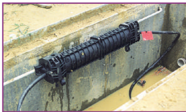
Installation en chambre
