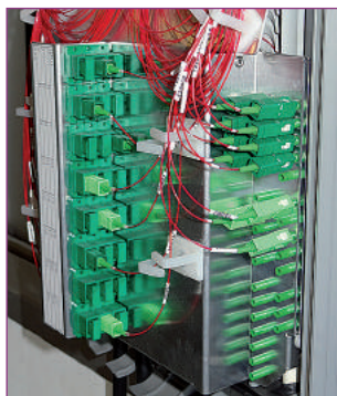
Platine de support de raccords et zone de pigtails en attente
